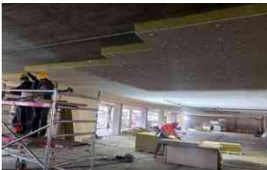
Solution d'isolation rapportée sous dalle
