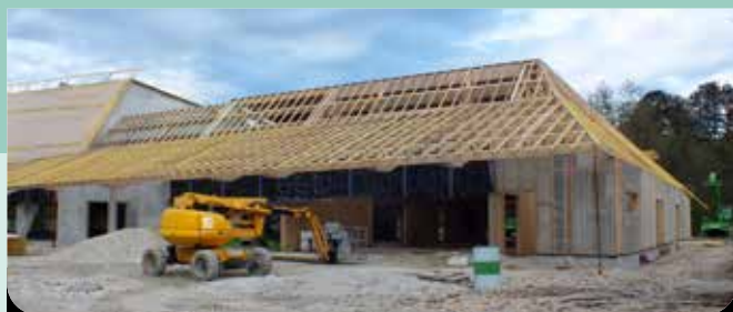
Octobre 2024 - Élévation des murs d'enceinte à ossature bois en béton de chanvre, salle polyvalente et cuisine.
