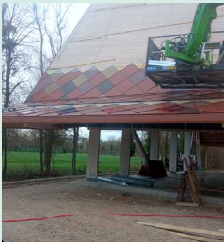
Décembre 2024 - Calepinage sur le côté ouest.
