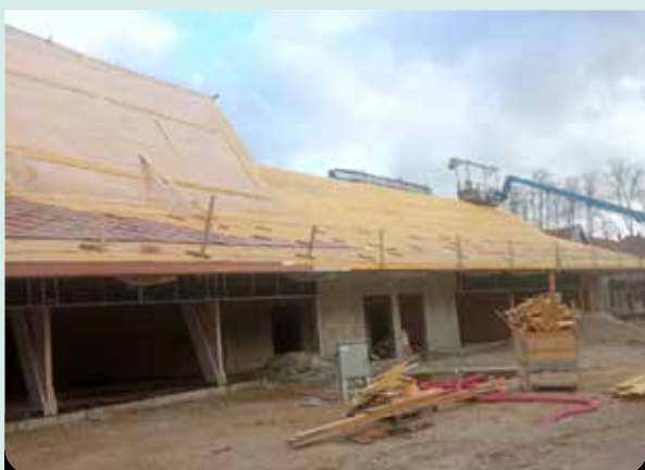
Décembre 2024 - Calepinage de la couverture.
