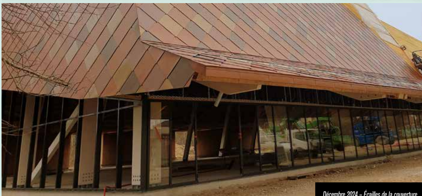
Décembre 2024 – Écailles de la couverture côté nord. Montage des baies vitrées.
