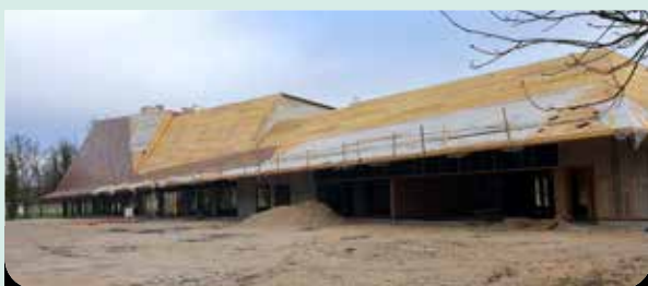
Décembre 2024 - Les écailles de couleurs en zinc couvrent déjà une partie du bâtiment.
