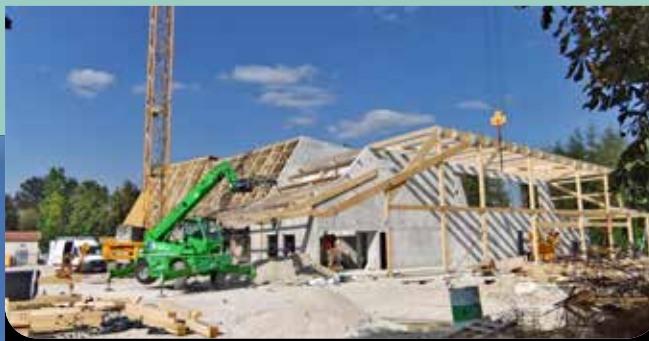
Septembre 2024 – Pose de la charpente de la salle polyvalente.
