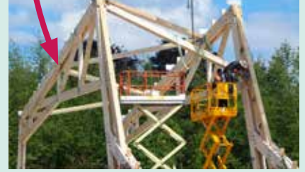
Juin 2024 - Les charpentiers assemblent les pièces de bois.
