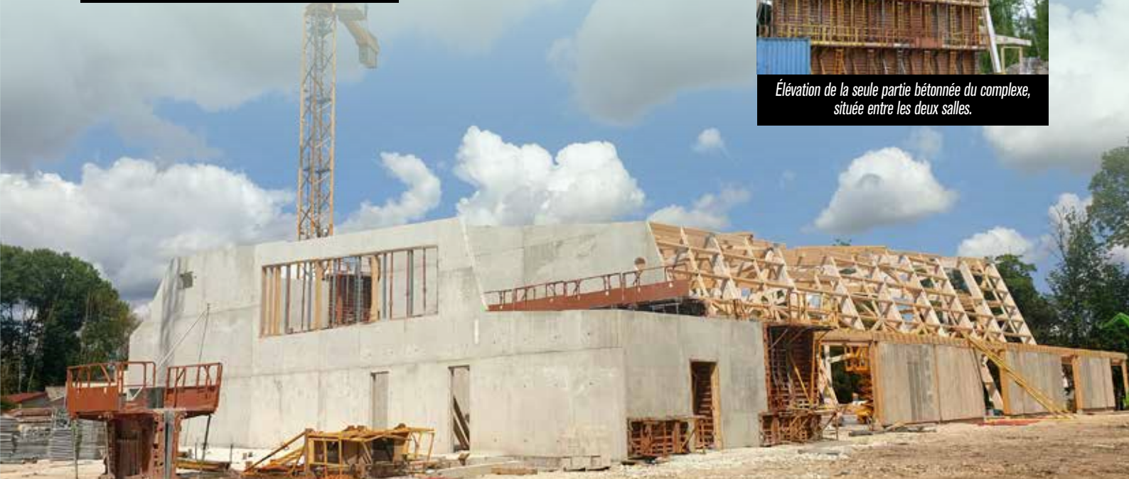
Juillet 2024 - Le mur de séparation est posé.
