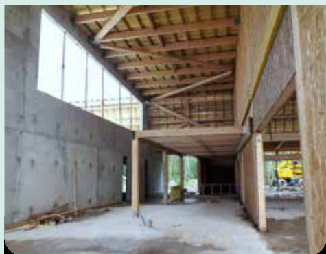
Octobre 2024 - Façade de la future cuisine.
