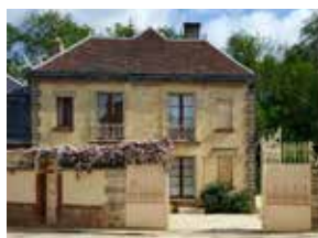
Maison paroissiale 8 rue Gambetta à Estissac
