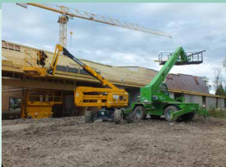
Les travaux, côté parc.
