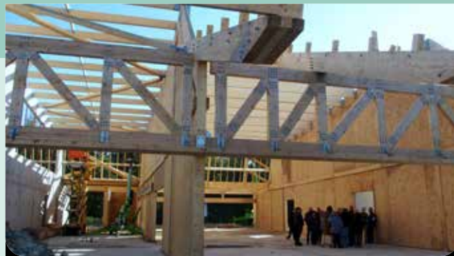
Octobre 2024 - Réunion du Conseil Municipal avec l'architecte, sur le chantier.
