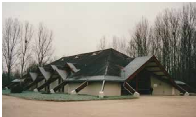
1996, couverture en shingles. Coll. P. Magnol
