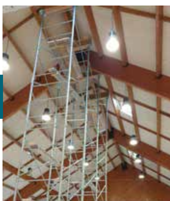
Échafaudage de soutien à l'intérieur du bâtiment
