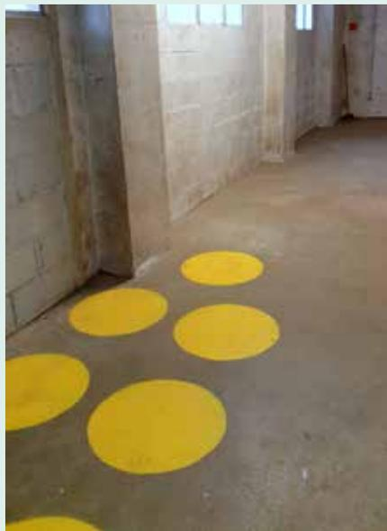
Marquage au sol pour contrôler le dépôt de poussière et prévenir les incendies et les explosions dues à une trop forte concentration de particules dans l'air.
