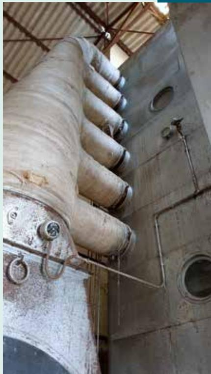
Tout au long de la manutention du grain, la poussière générée est captée à l'aide d'un système d'aspiration.
