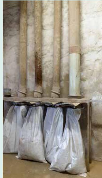
Cet air chargé de poussière est d'abord filtré avant d'être rejeté à l'extérieur. Les impuretés et les poussières sont dirigées vers la chambre à poussière et mis dans des sacs : après traitement, les issues collectées seront valorisées dans l'alimentation animale, pour le site d'Estissac. Sacs en vrac en dessous de la « machine à sacs manuelle ».
